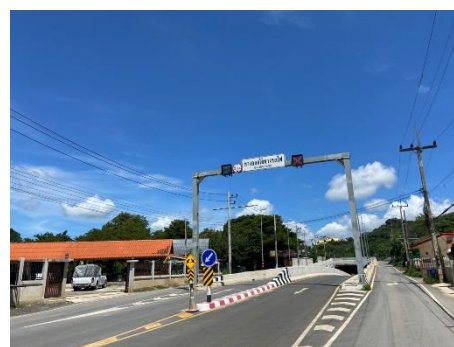
ภาพที่ 2.2-15 การติดตั้งไฟส่องสว่างและติดตั้งป้ายบอกระดับความสูงบริเวณทางลอดชุมชน
