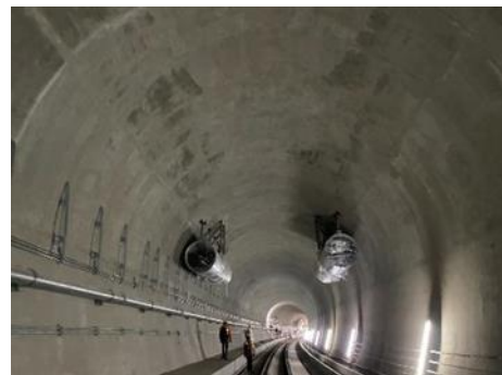
ภาพที่ 2.2-26 ระบบระบายอากาศภายในอุโมงค์
