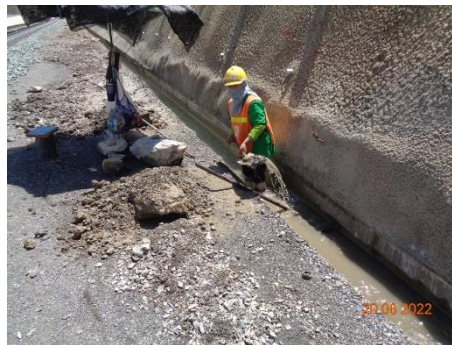
ภาพที่ 2.2-22 การขุดลอกกระบระบายน้ำ
