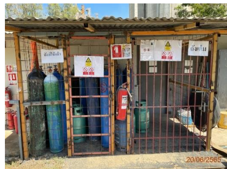
ภาพที่ 2.2-50 การวางถังแก๊สในแนวตั้ง
