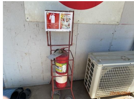
ภาพที่ 2.2-49 การติดตั้งถังดับเพลิง
