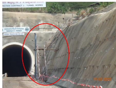
ภาพที่ 2.2-46 บันไดเข้า-ออก พื้นที่ทำการขุด
