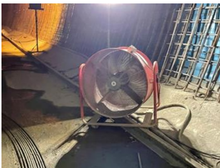
ภาพที่ 2.2-26 ระบบระบายอากาศภายในอุโมงค์
